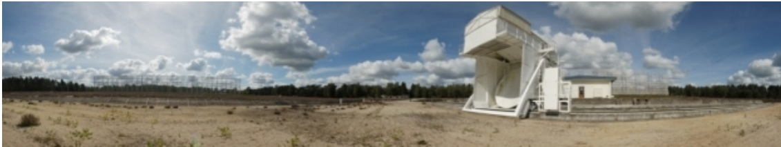
Vue panoramique du radiotélescope de Nançay (de gauche à droite : miroir fixe, chariot-récepteur et miroir mobile) Observatoire de Paris
